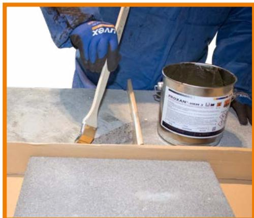
Затем на поврежденный участок с помощью кисточки обильно наносится усилитель адгезии PROXAN®- HRM 3. Обработка может осуществляться только в том случае, если температура основания как минимум на 3 К выше соответствующей температуры точки росы (более подробная информация содержится в „Общем допуске органов строительного надзора“ (abZ)).
