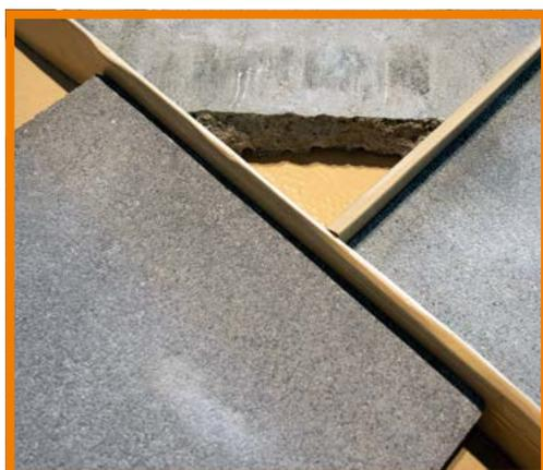
Основание должно быть сухим, прочным, без цементного молочка, пыли, несвязанных частиц, жира и масла. Это достигается за счет фрезерования, дробеструйной обработки, шлифования или очистки металлической щеткой. Затем несвязанные частицы удаляются сжатым воздухом. После предварительной обработки прочность сцепления с бетонным основанием должна составлять не менее 1,5 Н/мм<sup>2</sup>.
